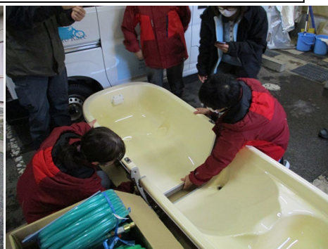
分割浴槽組立の様子
